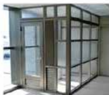
<会館3階喫煙ルーム>
