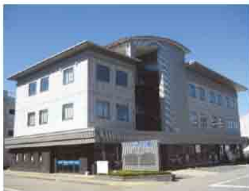
＜ユニオンプラザ福井外観＞
