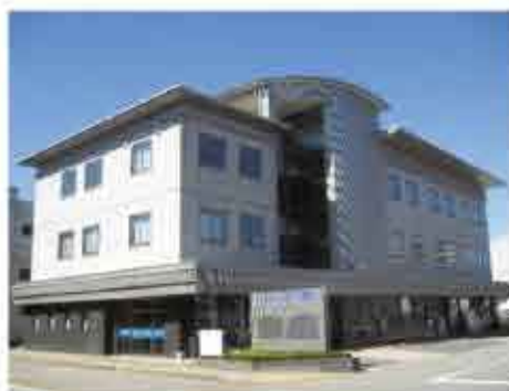
<ユニオンプラザ福井外観>
