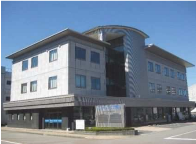
＜ユニオンプラザ福井外観＞
